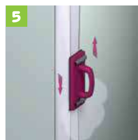
5 Se aplică un strat subțire de ipsos de îmbinări pe partea de deasupra a benzii și așteptați până se usucă complet, șlefuiți suprafața uscată utilizând șmirghel cu granulație de min. 200
